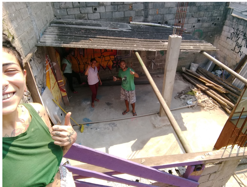
Limpeza e organização para início da obra feita por voluntários e membros do coletivo Reviveno
