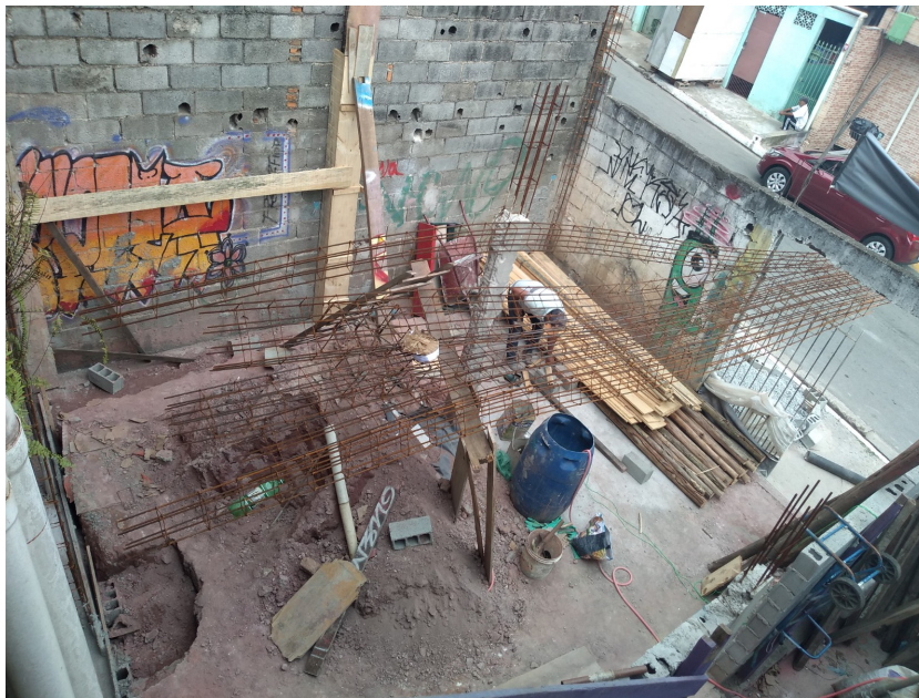
Pedreiro na construção da fundação, sapatas, colunas e vigas
