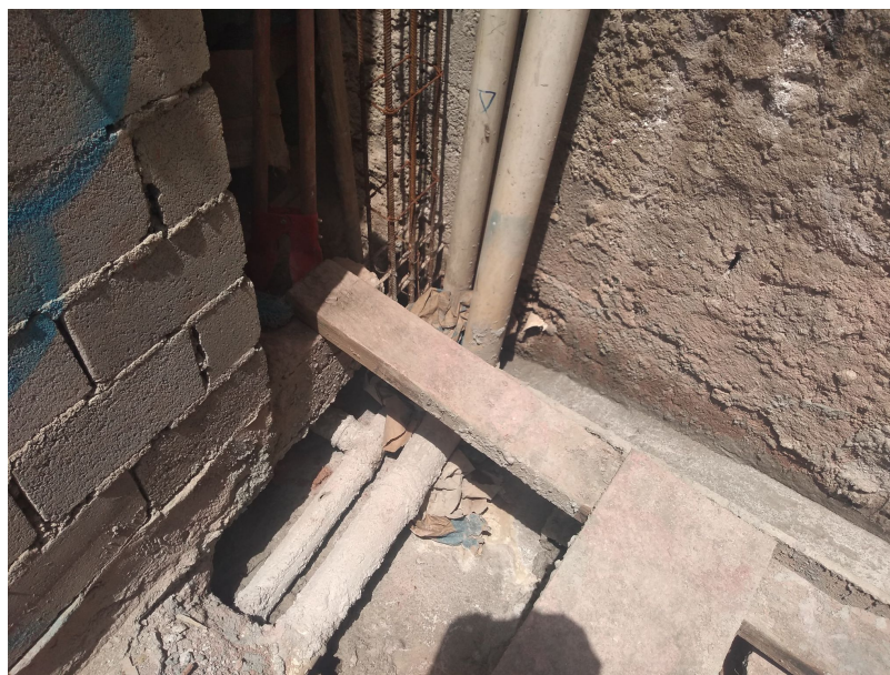
Construção das sapatas, colunas e vigas
