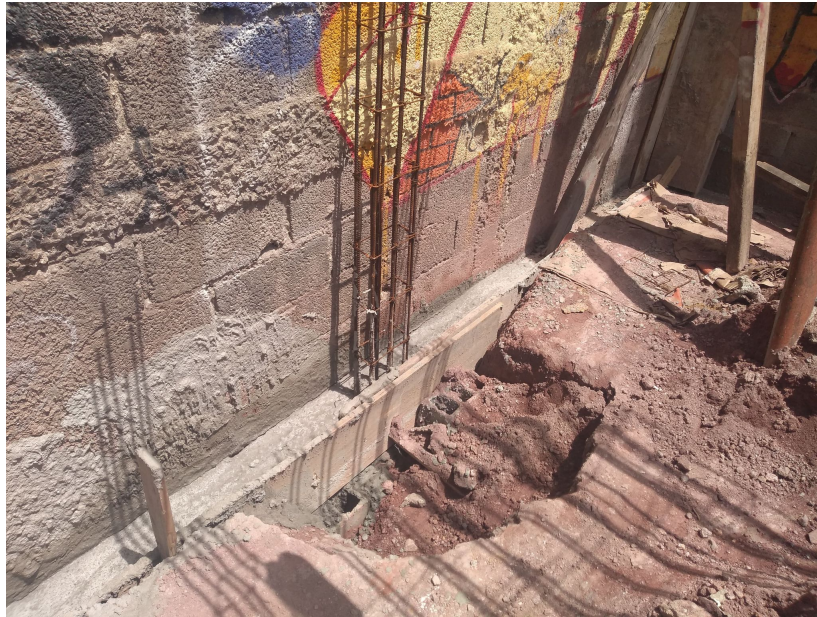
Construção da fundação da obra
