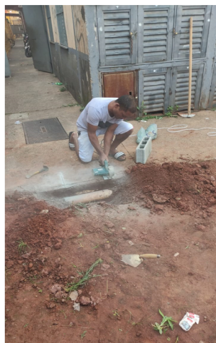
Desentupimento e criação de caixa de acesso para escoação de águas pluviais
