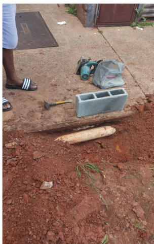
Desentupimento e criação de caixa de acesso para escoação de águas pluviais
