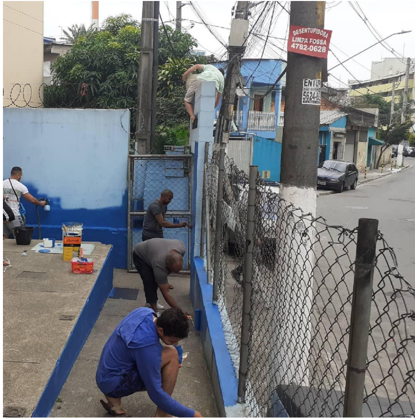
Revitalização da frente dos blocos (entradas)
