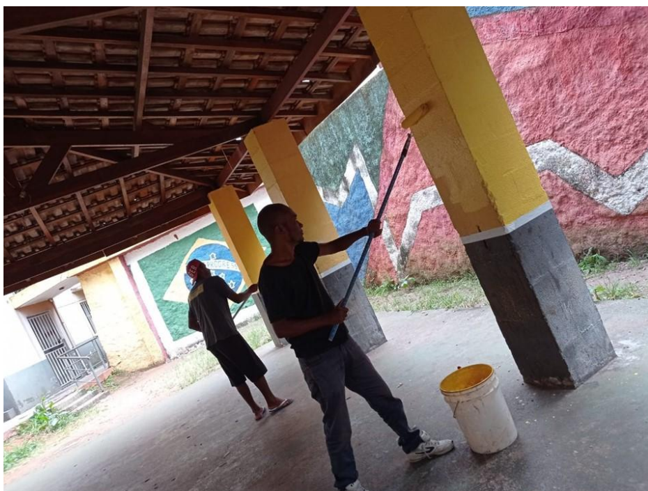
Pinturas das paredes e colunas do quiosque comunitário
